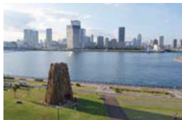
竣工した「豊洲ドーム」。1年に渡り移り行く景観を見つめ続けます。
