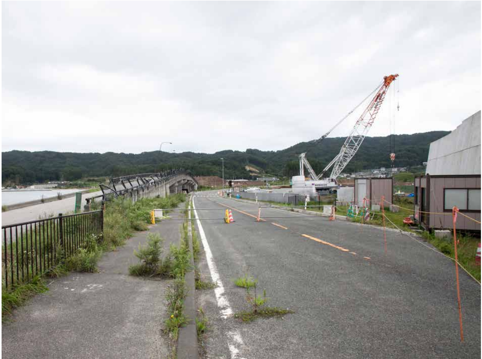
写真左には、吉里吉里海岸に続く橋が壊れたままになっている。写真右には、新しい防潮堤が建設中。中央は旧国道45号線。
