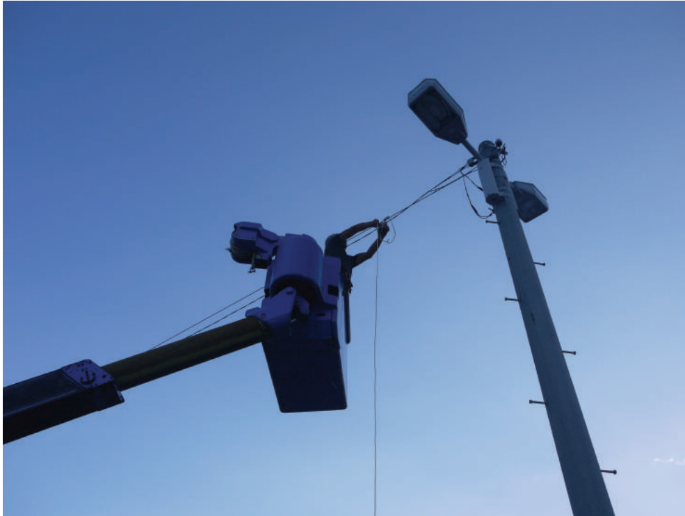
朝 6 時の中棧橋にて、滑車の取り付け作業中
